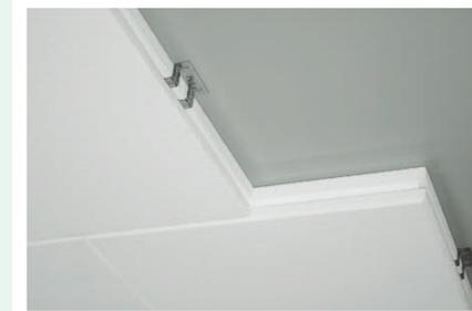
Die Kellerdecken-Dämmplatten mit gefaster Kante und umlaufender Nut+Feder- oder Stufenfalzausbildung.
