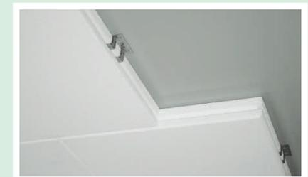
Die nachträgliche Dämmung der Kellerdecke mit Kellerdecken-Dämmplatten – geklebt oder mechanisch befestigt.
