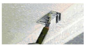
Alternativ können auf nicht tragfähige Untergründe zur Befestigung der Kellerdecken-Dämmplatten Dämmstoff-Haltekrallen verwendet werden. Für eine sichere Montage wird die Kralle in die Wange der Nut eingesteckt.
